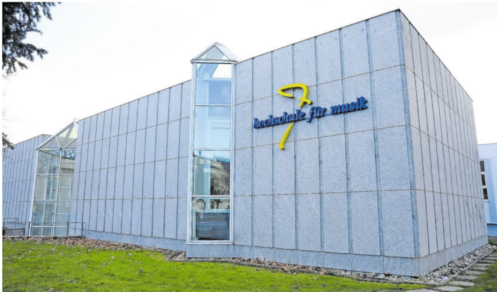
Sieht von außen solider aus, als sie in Wirklichkeit ist: Die Hochschule für Musik in der Saarbrücker Bismarckstraße neben dem Staatstheater kämpft seit Jahren mit einem Sanierungsstau.
