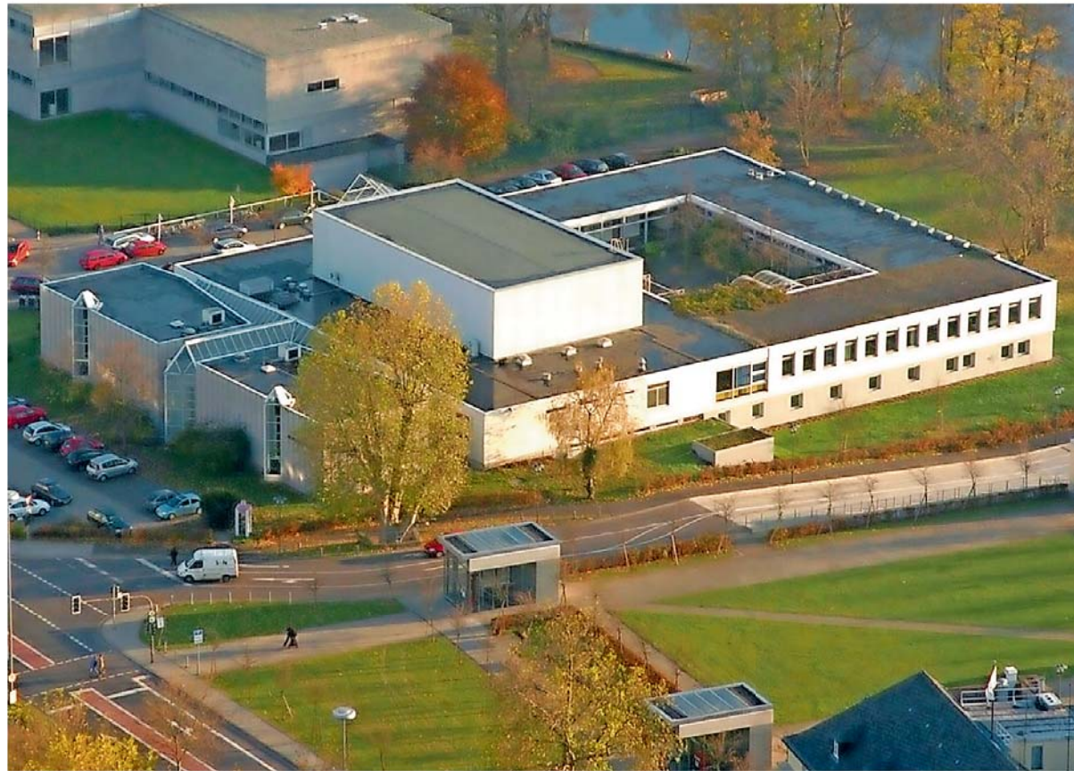
Luftaufnahme der Musikhochschule (von 2005): Rechts ist das Hauptgebäude zu sehen, links davon der Hanus-Bau: Erweiterungsbau aus den 80ern. Beide Gebäudekomplexe haben Sanierungsbedarf. Gibt ihre Bausubstanz das her? FOTO: BECKER&BREDEL
