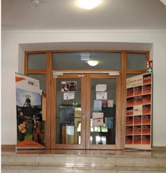
Eingangsbereich der alten Kirche
